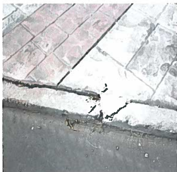
Foto N° 17 – Intersección de avenida Sargento Aldea con pasaje Mataveri.
