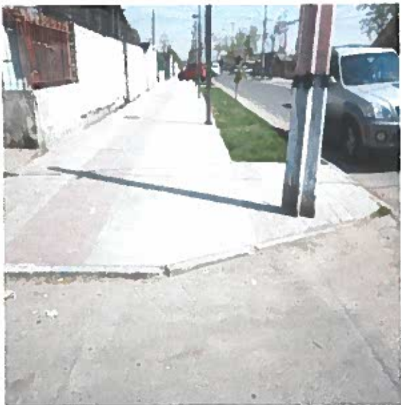
Foto N° 44 – Intersección de avenida Tomé con calle Díez Oriente.
