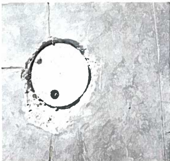
Foto N° 61 – Avenida Los Vilos Sur entre avenida Combarbalá y avenida Linares.
