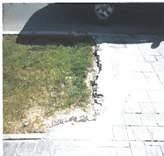
Foto N° 53 – Avenida Tomé entre avenida Los Vilos y calle Ocho Poniente.
