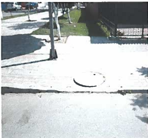
Foto N° 19 – Intersección de avenida Sargento Aldea con calle Cóndores de Chile.
