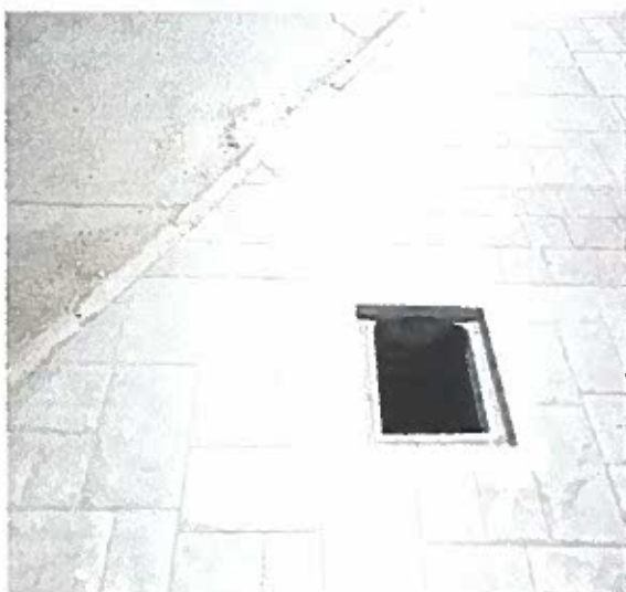
Foto N° 63 – Intersección avenida Tomé con calle Diez Oriente.
