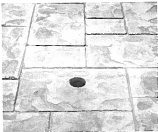
Foto N° 25 – Avenida Los Vilos Sur entre avenida San Gregorio y calle Uno Sur.
