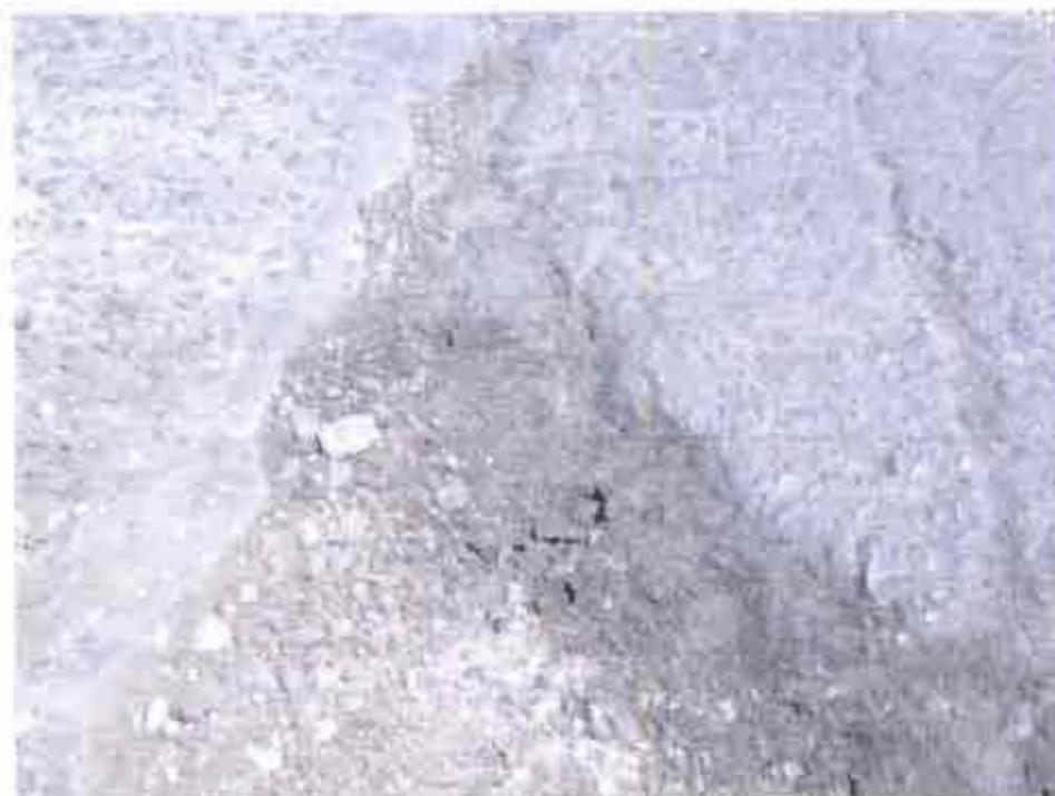
Fotografía N° 16. Zona de junta mezclas asfálticas nueva y antigua
