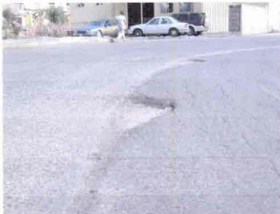
Fotografía N° 15. Zona de junta mezclas asfálticas nueva y antigua
