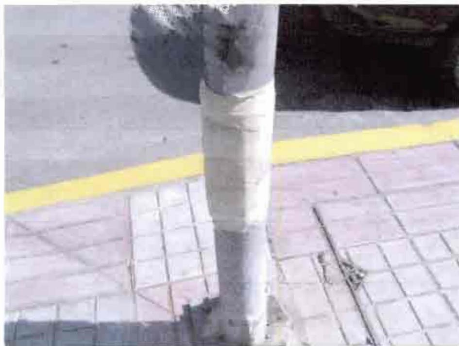
Fotografía N° 20. Poste de luz reinstalado
