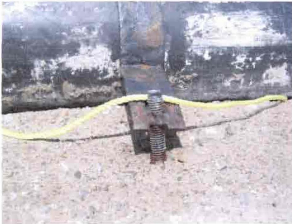
Fotografía N° 31. Abrazaderas soldadas a los pernos.
