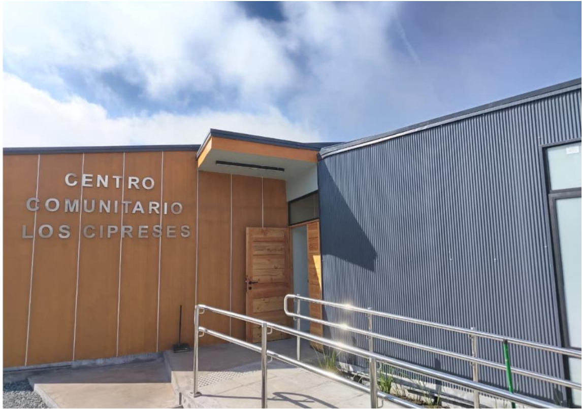
Recepción provisoria obra “CENTRO COMUNITARIO LOS CIPRESES COMUNA DE LINARES”.
