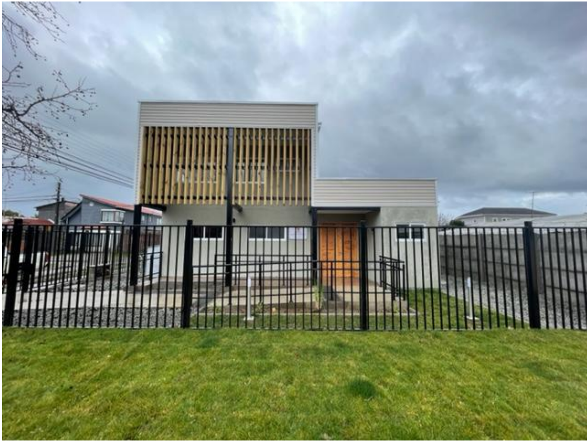
Recepción definitiva obra “CONSTRUCCIÓN SEDE SOCIAL MAGISTERIO NORTE, LINARES”.
