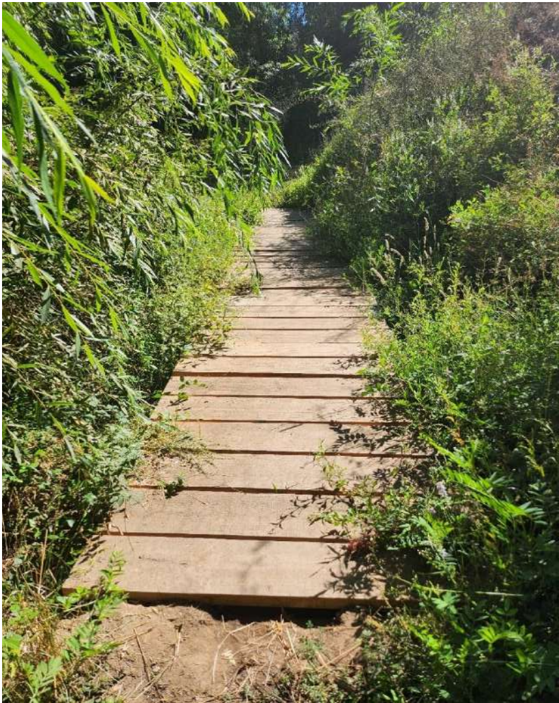
PUENTE SEGUNDA PASARELA
