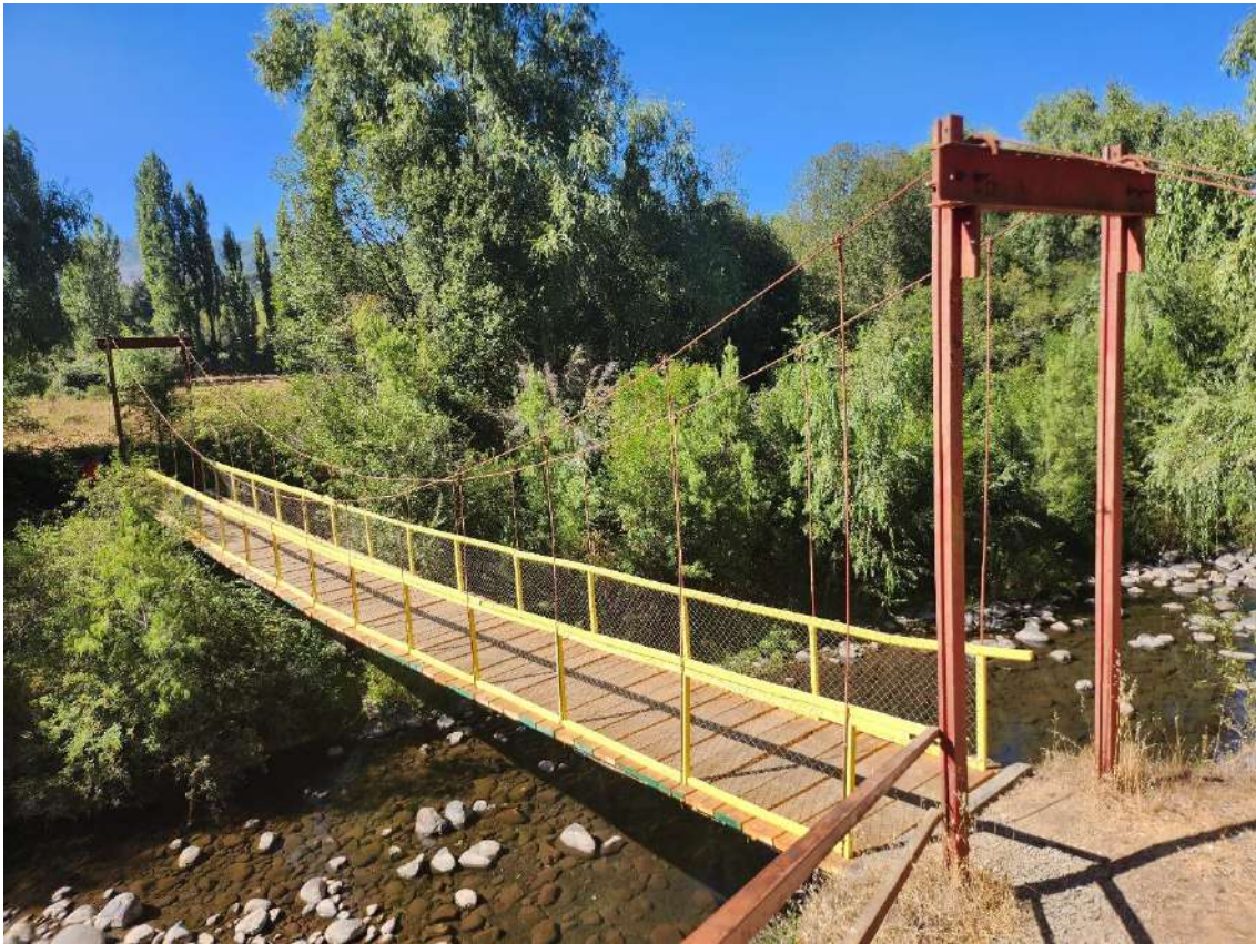
PRIMERA PASARELA EN VEGA DE SALAS
