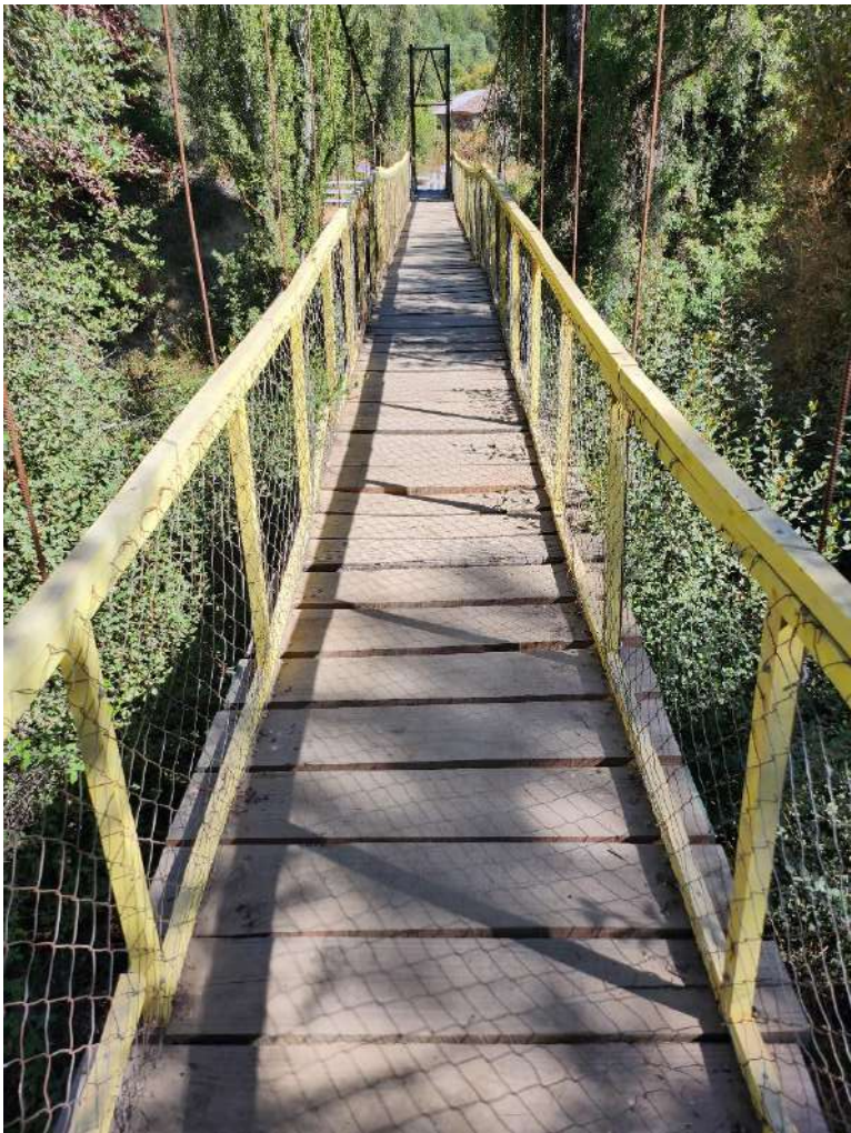
SEGUNDA PASARELA VEGA DE SALAS
